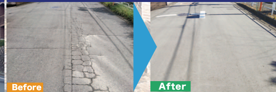
道路舗装による安全性の向上・振動の低減 / 川島町
