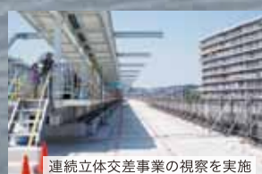
連続立体交差事業の視察を実施
